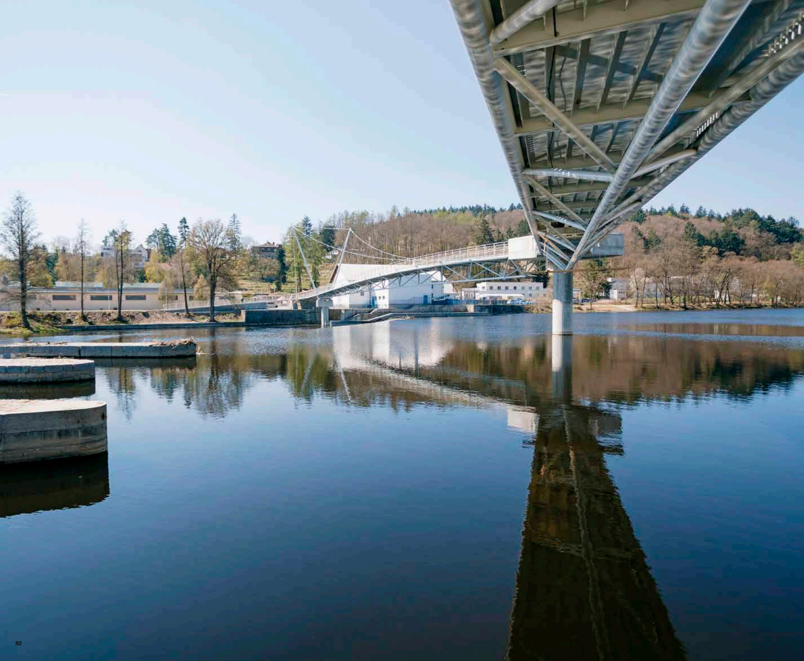
Pěší lávka přes Otavu Footbridge over the Otava river
