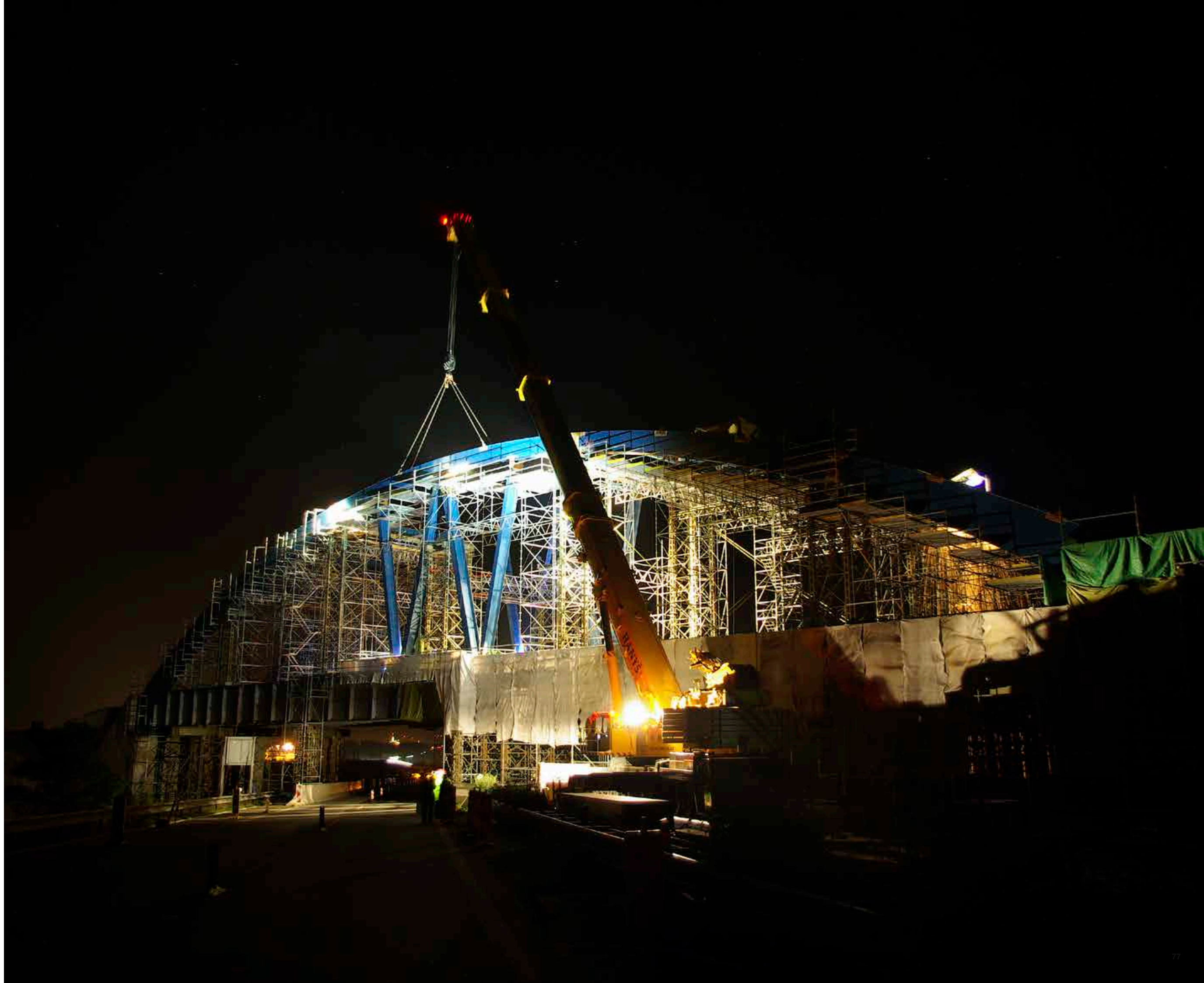
Železniční most u Tábora Railway bridge near Tábor
