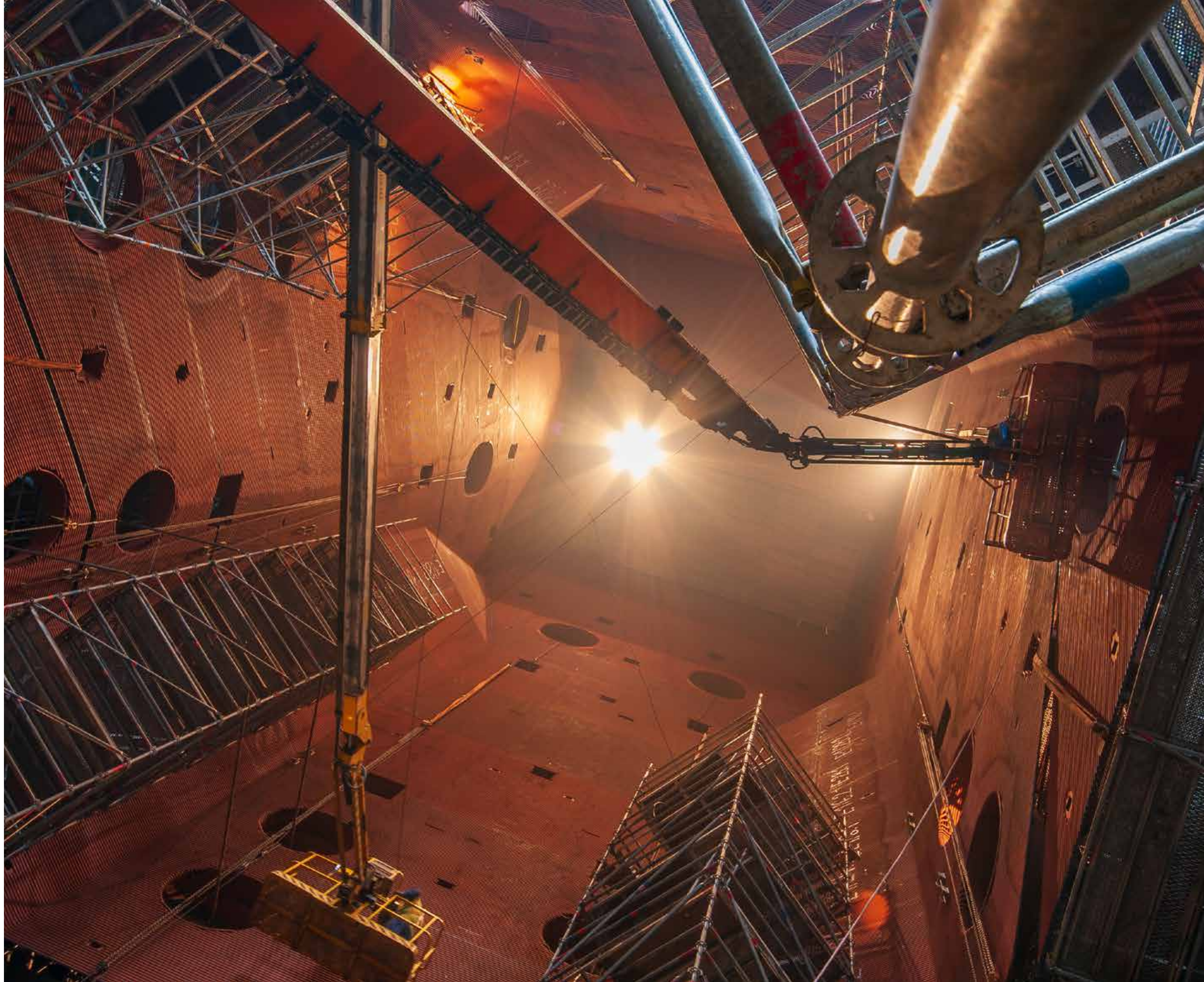
Výměna kotlů v Prunéřově Exchange of boilers in Prunéřov
