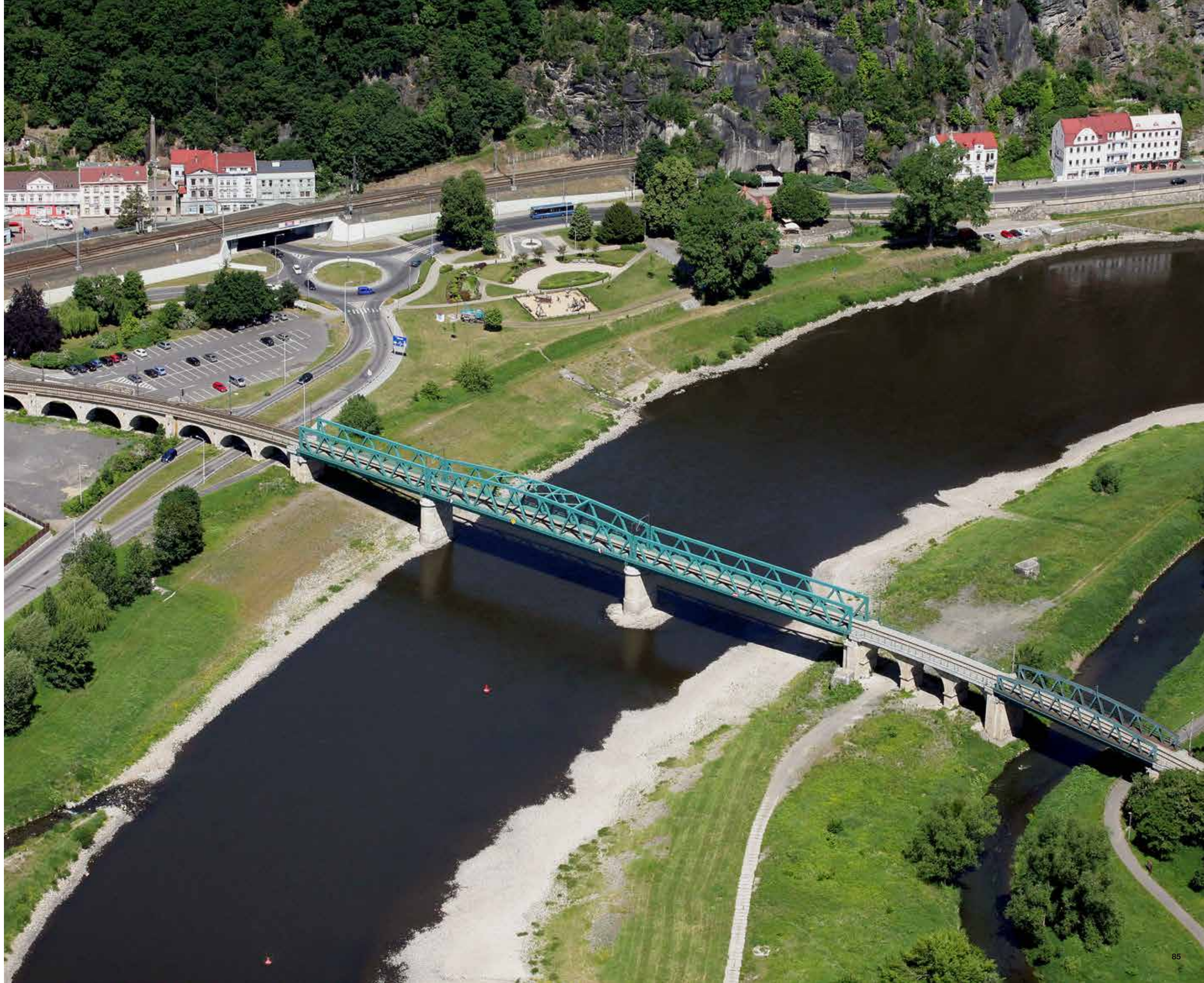
Železniční most v Děčíně Railway bridge in Děčín
