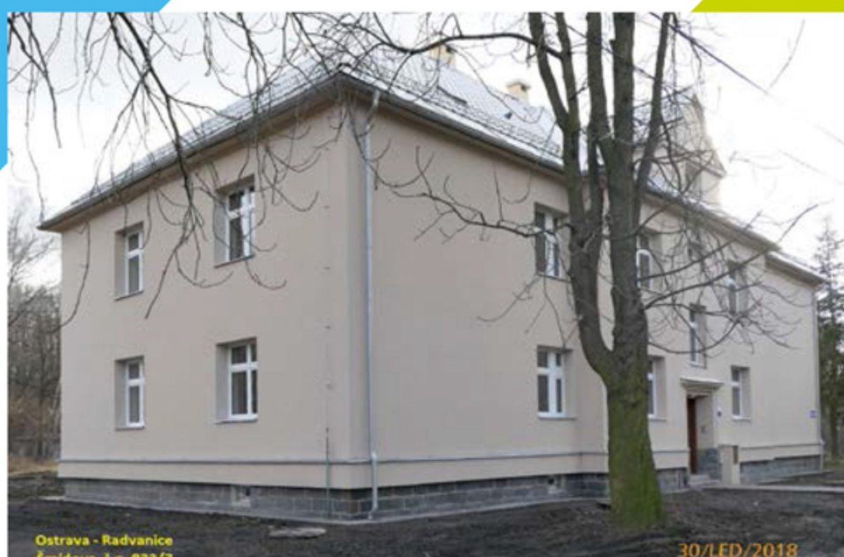
KOMPLETNÍ REKONSTRUKCE BYTOVÉHO DOMU ul. Šmídova 833 9 600 000,-
