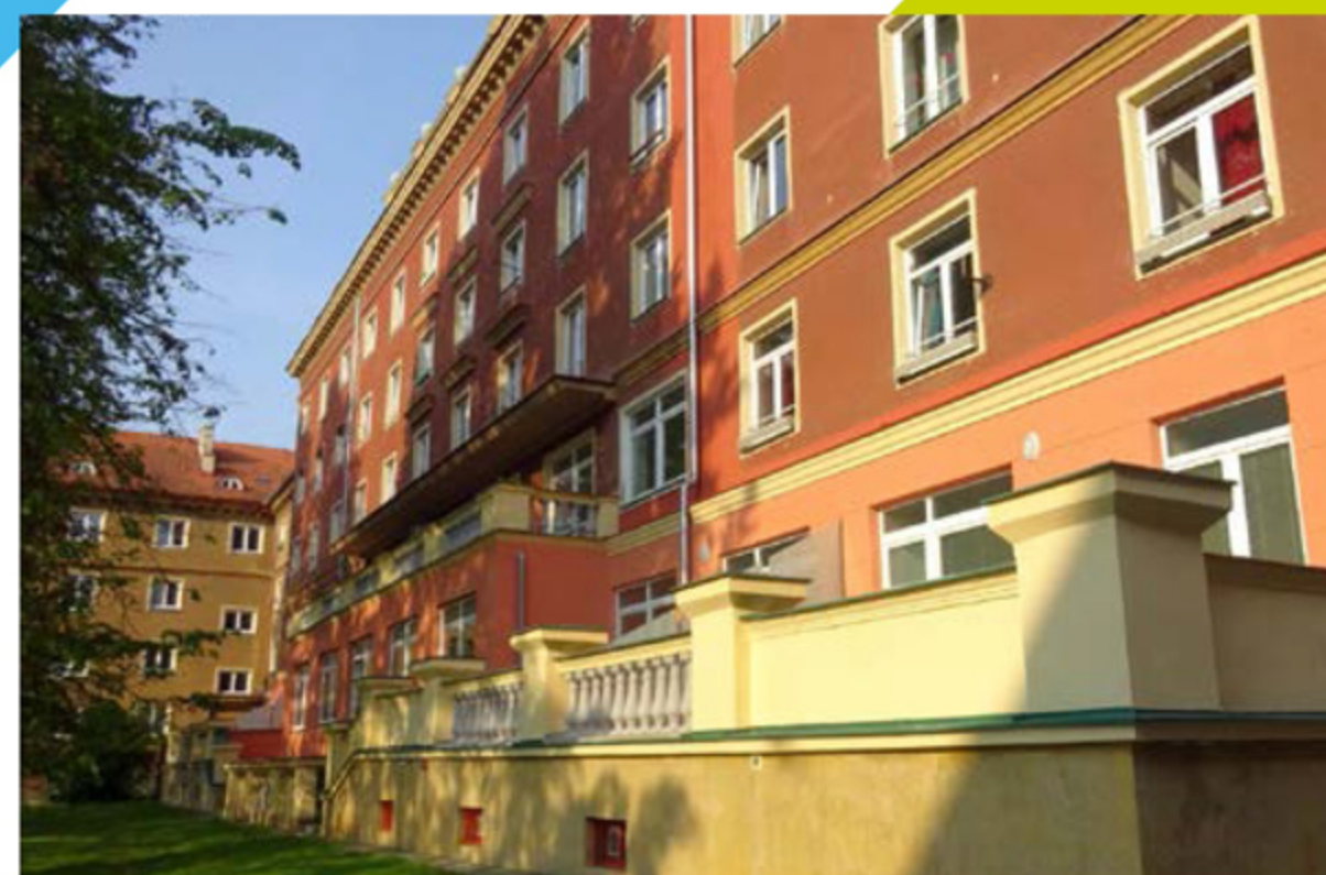
REKONSTRUKCE NEBYTOVÉHO PROSTORU (BÝVALÉ MŠ) NA BYTOVÉ JEDNOTKY nám. Jana Nerudy 613, 614, 615 9 900 000,-
